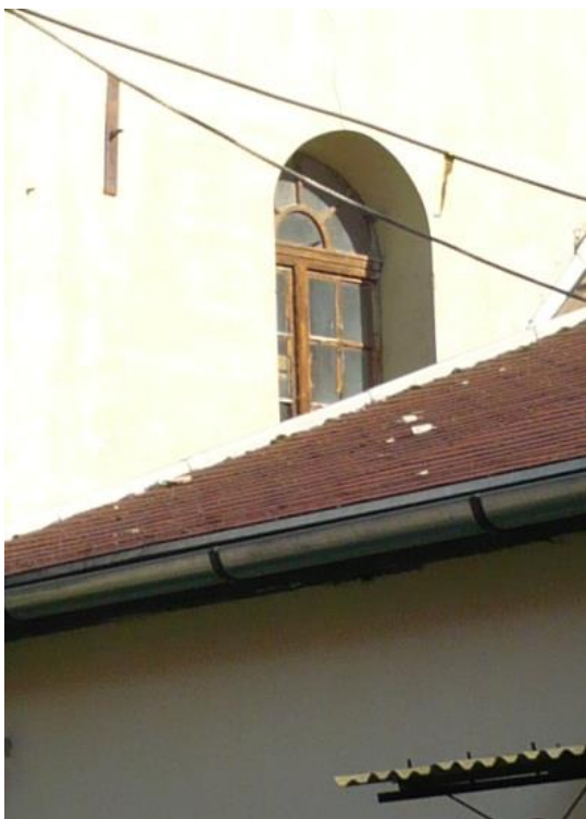
14. kép: Az oldalhomlokzat ablaka
