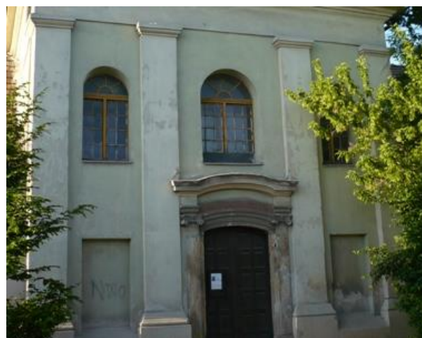
11. kép: A főhomlokzat pilaszterei
