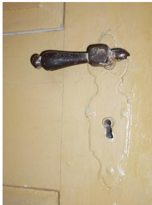
17. kép: Az ajtó eredeti zárszerkezete
