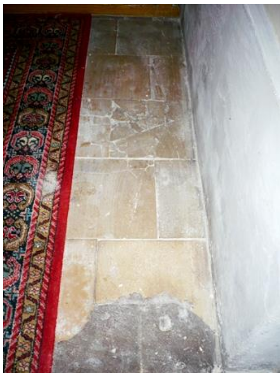
27. kép: Kő burkolat a keleti padsor alatt
